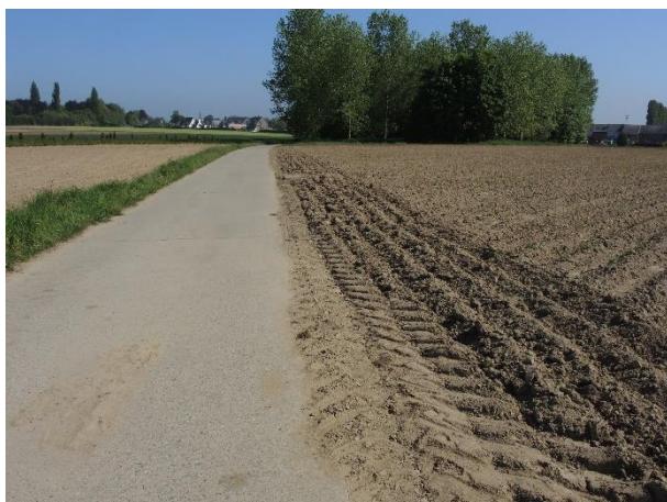
FIGUUR 21: EEN INGEploEGDE BERM IN DE ERPSEWEG
